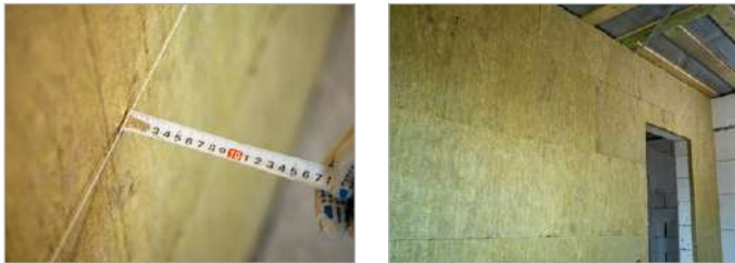
Рис. 10. Монтаж звукоизоляции
