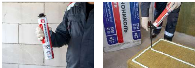
Рис. 6. Подготовка баллона и нанесение клея-пены
