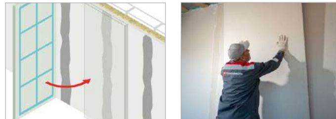
Рис. 15. Крепление листов ГКЛ/ГВЛ второго слоя
