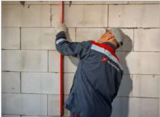
Рис. 3. Определение кривизны стены
