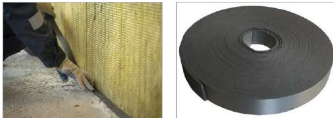
Рис. 11. Укладка виброизоляционной ленты
