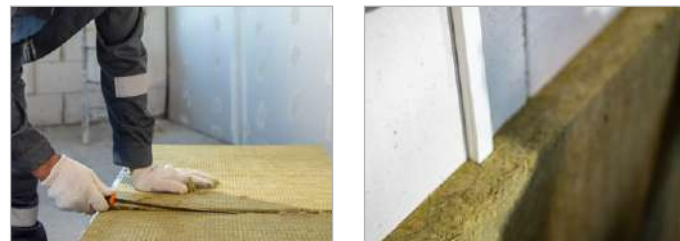
Рис. 9. Вырезанные борозды в плитах каменной ваты под кабель-канал
