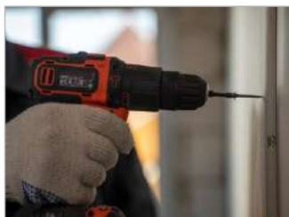
Рис. 16. Крепление листов ГКЛ/ГВЛ второго слоя
