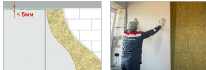
Рис. 13. Монтажный зазор
