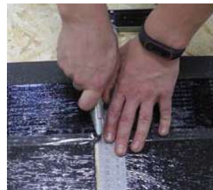
Рис. 75. Деление плитки на лепестки
