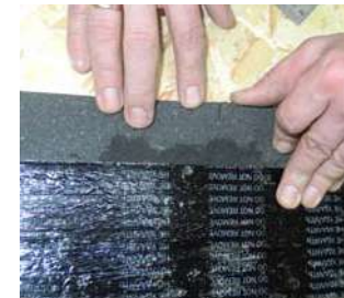
Рис. 74. Насечка для облегчения монтажа
