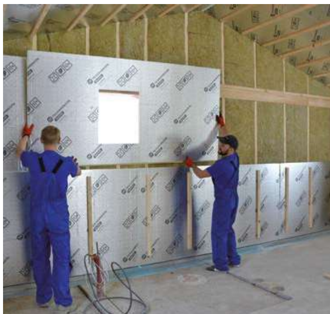
Контрутепление стен
