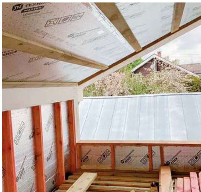
Контрутепление скатной кровли
