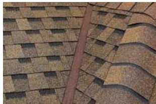
Калифорнийская ендова (один из вариантов открытого способа)
