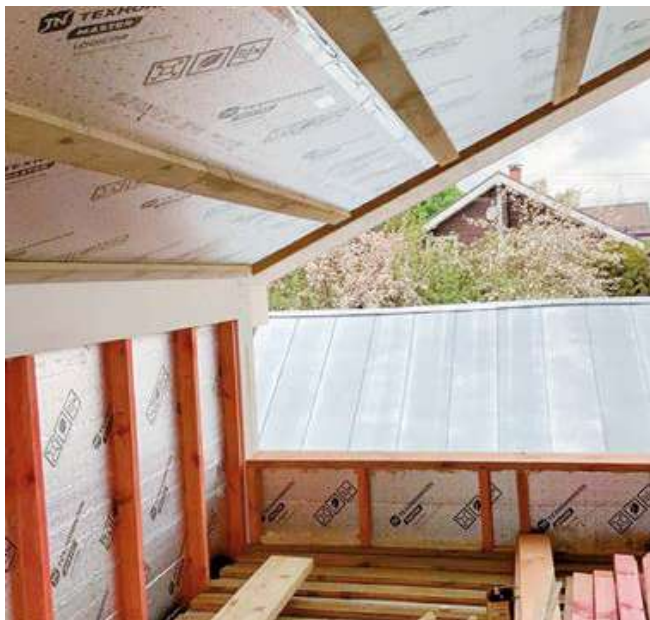
Контрутепление скатной кровли
