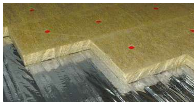
Рис. 3.10. Укладку теплоизоляционных плит по профилированному листу
