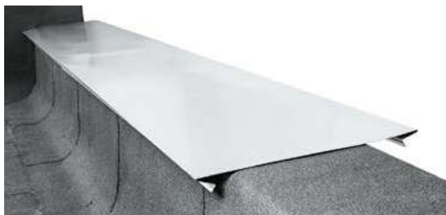
Рис. 3.29. Установка парапетной крышки
