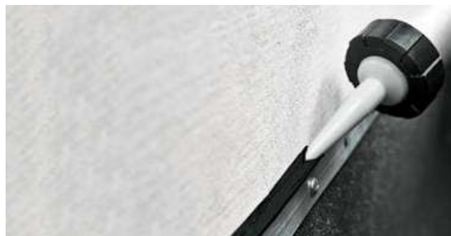
Рис. 3.24. Герметизация края краевой рейки
