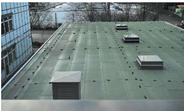
Рис. 3.56. Устройство молниеприемной сетки на кровле
