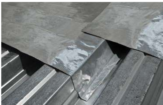
Рис. 3.6. Формирование продольного нахлеста пароизоляции на профлисте
