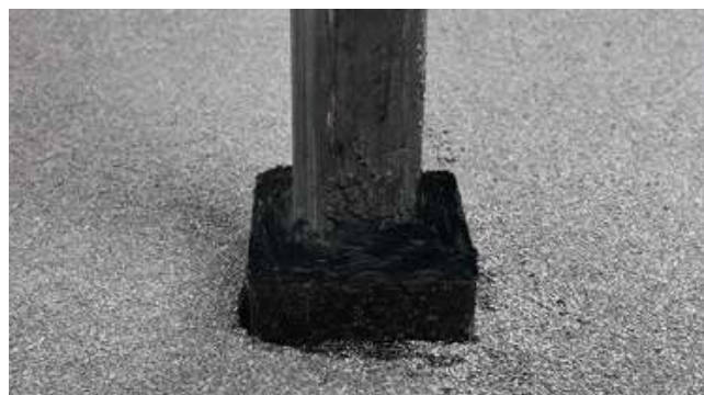
Рис. 3.37. Примыкание кровли к трубам малого диаметра
