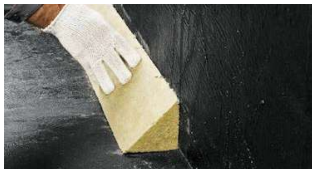
Рис. 3.13. Устройство наклонного бортика
