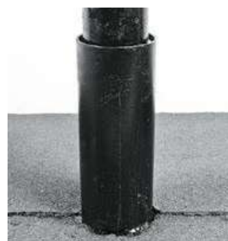
Рис. 3.33. Примыкание кровли к трубе
