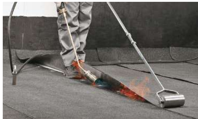
Рис. 3.46. Сварка шва с использованием газовой горелки
