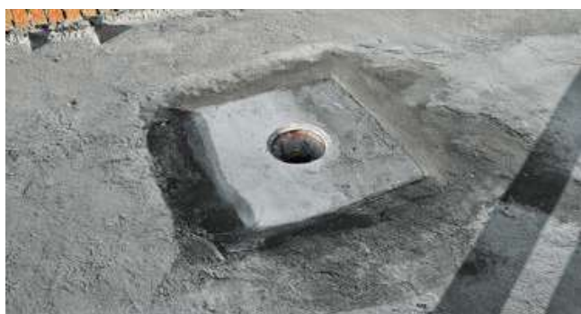
Рис. 3.12. Локальное понижение в месте установки воронки
