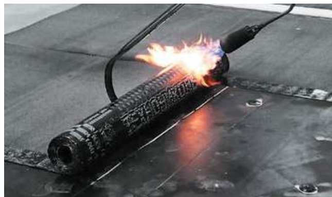
Рис. К.1. Наплавление по теплоизоляционным плитам
