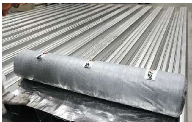
Рис. 3.5. Укладка пароизоляционного материала по профлисту
