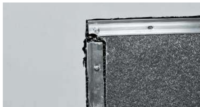
Рис. 3.23. Обрамление края кровельного ковра краевой рейки
