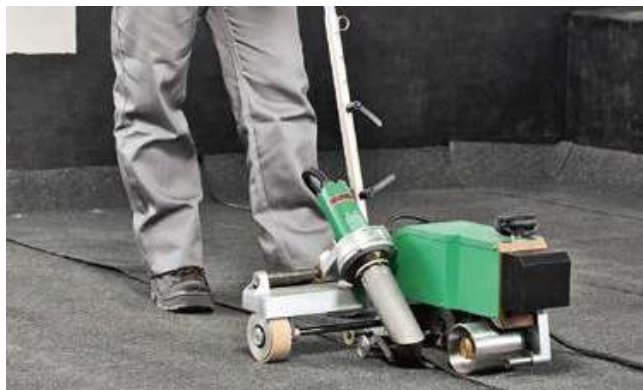
Рис. 3.45. Сварка шва автоматическим оборудованием
