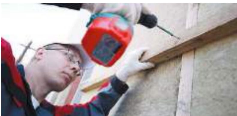
Рис. 7.3. Установка горизонтального каркаса
