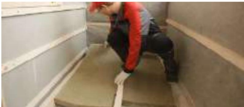
Рис. 7.50. Укладка теплоизоляционных плит
