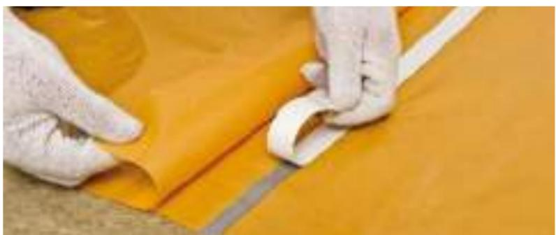
Рис. 5.3. Монтаж и проклейка нахлестов пароизоляционной пленки
