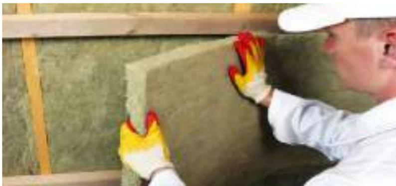
Рис. 4.4.б. Укладка второго слоя теплоизоляции
