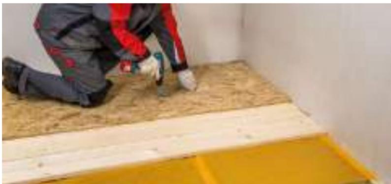
Рис. 5.4.б. Монтаж чернового пола
