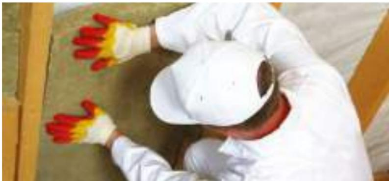
Рис. 4.3.б. Монтаж теплоизоляции враспор между стропилами
