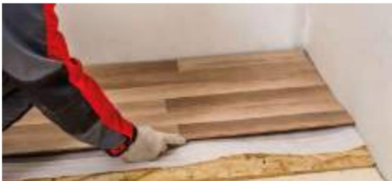
Рис. 5.5. Монтаж чистового покрытия
