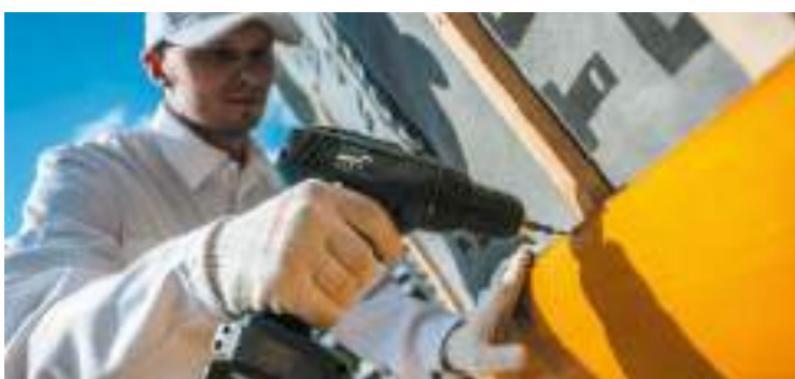
Рис. 7.23.а. Монтаж облицовочного материала
