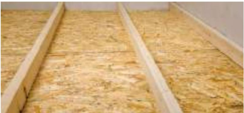
Рис. 5.1. Подшивка лаг снизу
