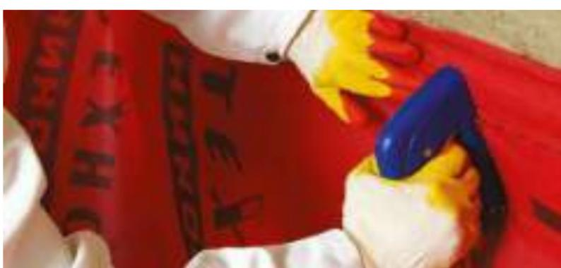
Рис. 4.5. Укладка и фиксация пароизоляционной пленки
