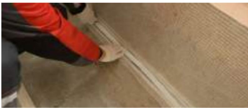
Рис. 7.52. Проклейка нахлестов пароизоляции
