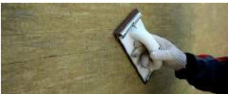
Рис. 7.34. Шлифовка стыков плит теплоизоляции наждачной бумагой
