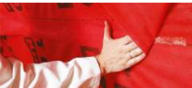
Рис. 4.6. Проклейка стыков пароизоляционной пленки
