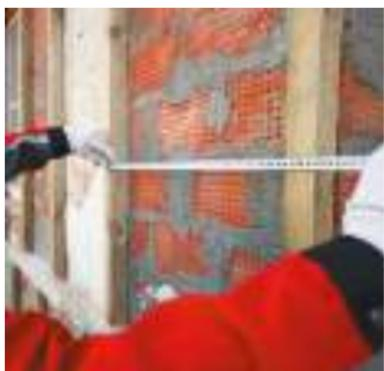
Рис. 7.1. Крепление вертикальных стоек деревянного каркаса
