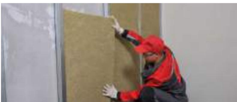
Рис. 6.11. Монтаж тепло-, звукоизоляционных плит
