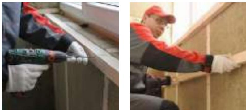
Рис. 7.44. Установка горизонтального каркаса под теплоизоляцию
