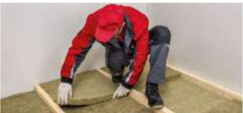
Рис. 5.2. Монтаж теплоизоляции враспор между лагами
