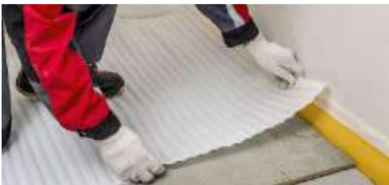
Рис. 5.14. Укладка подложки под финишное покрытие пола
