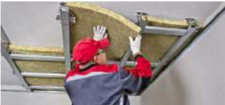
Рис. 5.21. Укладка плит ТЕХНОАКУСТИК
