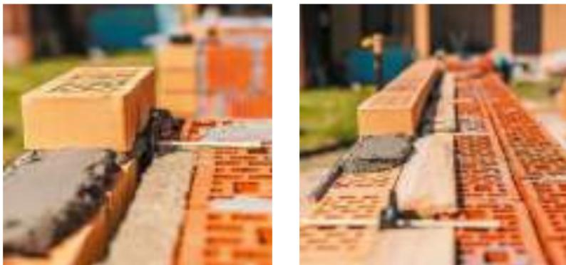
Рис. 7.15. Монтаж внешней версты после установки гибких связей
