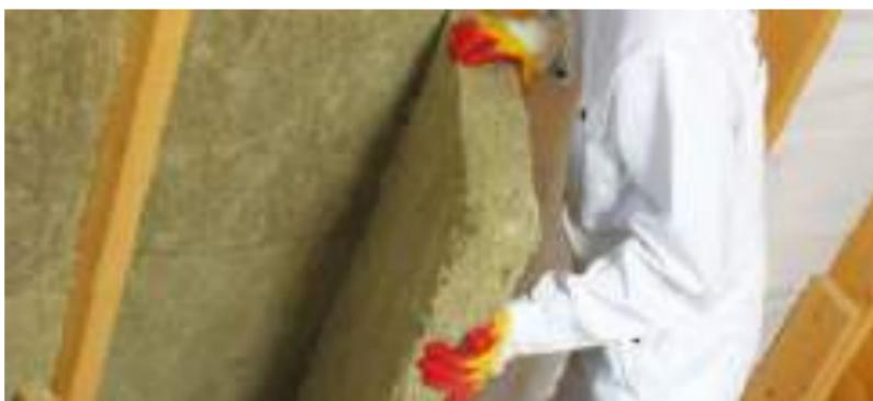
Рис. 4.3.а. Монтаж теплоизоляции враспор между стропилами
