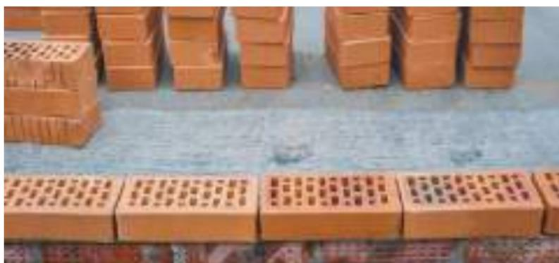
Рис. 7.8. Гидроизоляционная отсечка
