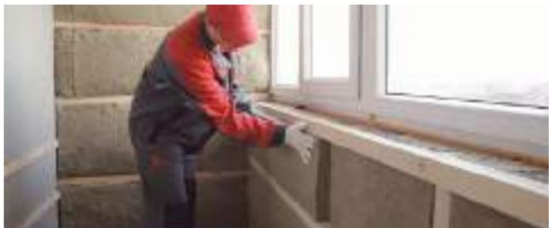
Рис. 7.45. Укладка плит теплоизоляции второго слоя
