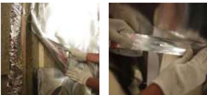
Рис. 6.16. Проклейка стыков пароизоляции
