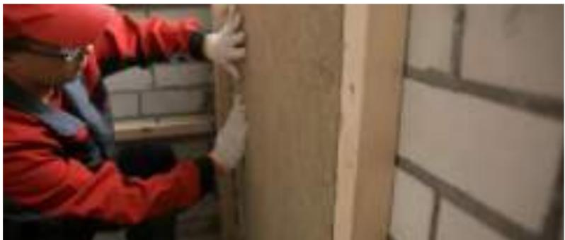
Рис. 7.43. Укладка плит теплоизоляции первого слоя
