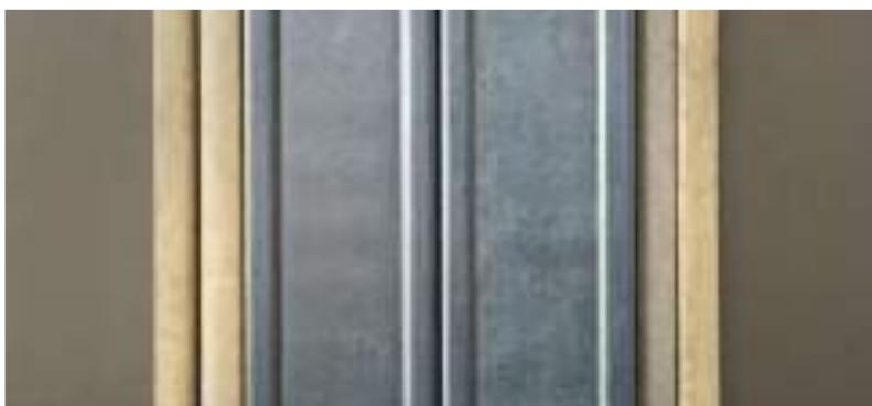
Рис. 6.7. Обшивка второй стороны перегородки листами ГКЛ
