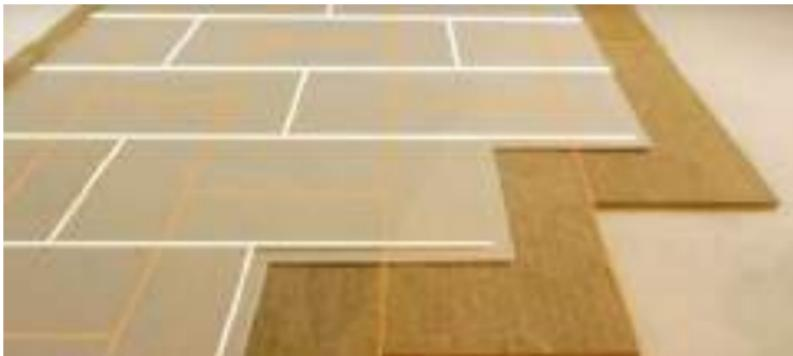
Рис. 5.12. Разбежка швов сухой стяжки и звукоизоляционных плит
