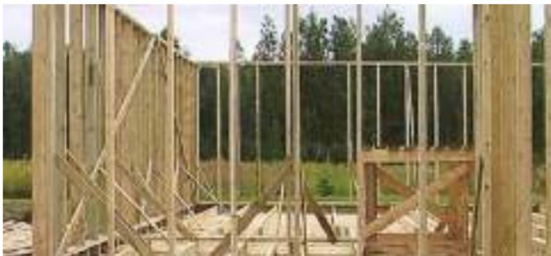
Рис. 7.19. Установка деревянного каркаса
