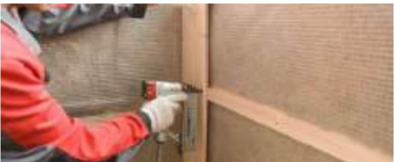
Рис. 7.48. Устройство внутренней обшивки
