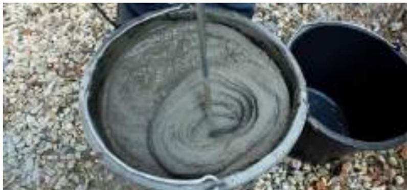
Рис. 7.27. Замешивание клея для приклейки теплоизоляции
