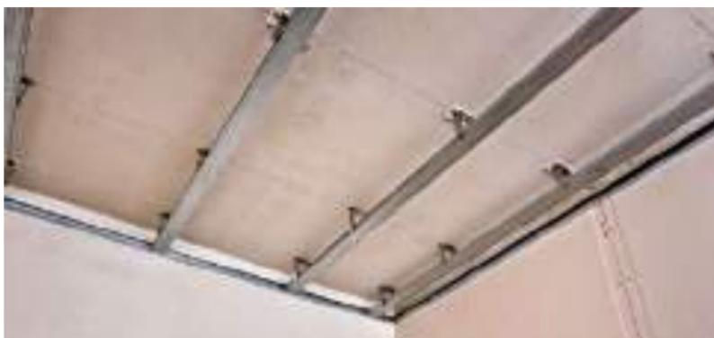
Рис. 5.20. Установка подвесов и потолочного профиля
