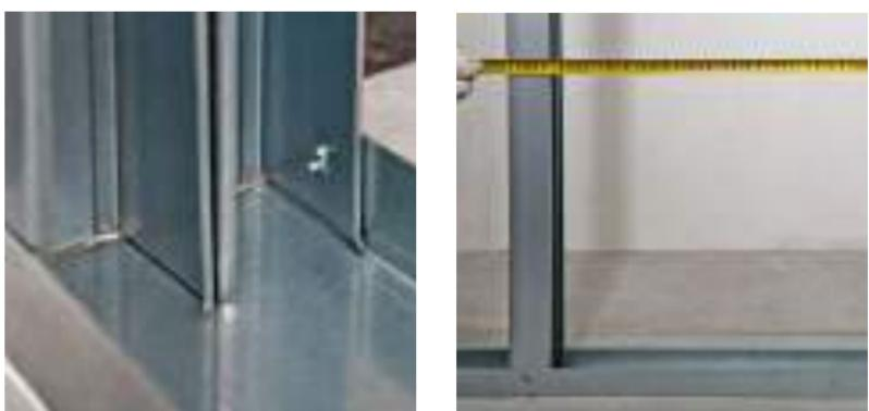
Рис. 6.4. Установка стоечного профиля.
