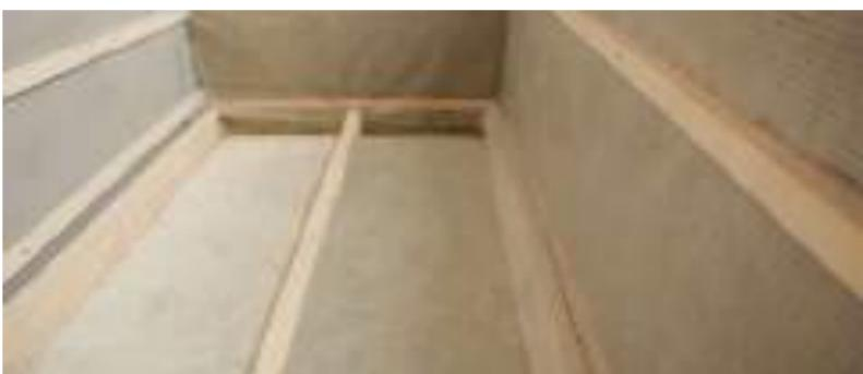
Рис. 7.49. Монтаж деревянных лаг на пол
