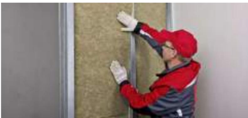
Рис. 6.6. Укладка плит ТЕХНОАКУСТИК
