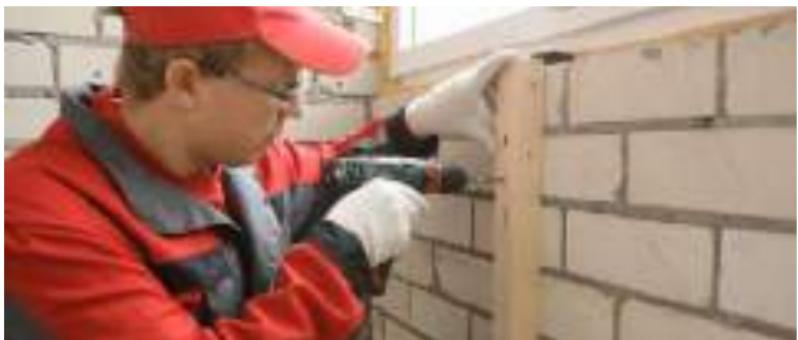
Рис. 7.42. Установка вертикального каркаса под теплоизоляцию
