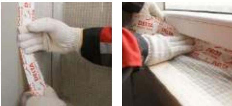
Рис. 7.53. Проклейка примыканий пароизоляции к стенам и окну
