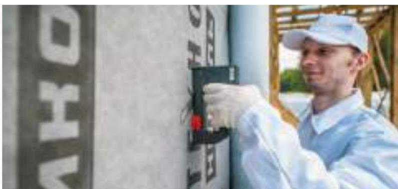
Рис. 7.22. Монтаж ветро-, влагозащитной мембраны
