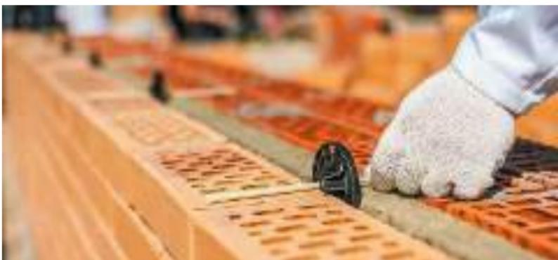
Рис. 7.14. Установка гибких связей
