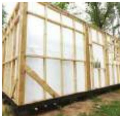
Рис. 7.20. Монтаж пароизоляционной пленки
