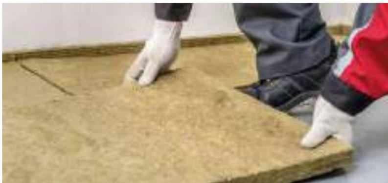
Рис. 5.8. Укладка плит ТЕХНОФЛОР СТАНДАРТ
