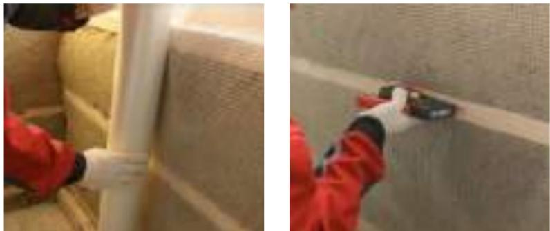
Рис. 7.46. Монтаж пароизоляции
