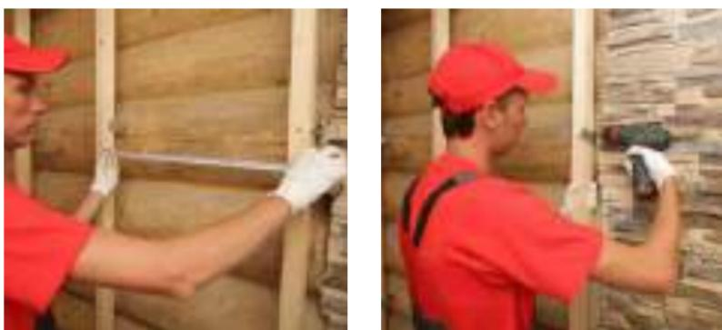
Рис. 6.13. Установка каркаса под теплоизоляцию
