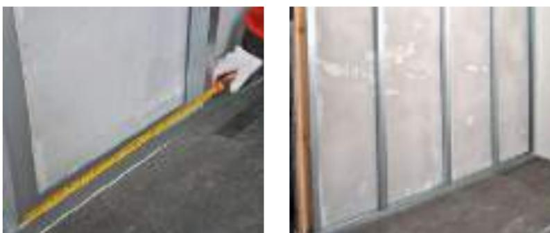
Рис. 6.10. Установка направляющего и стоечного профилей
