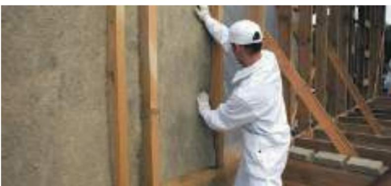
Рис. 7.21. Монтаж теплоизоляционных плит
