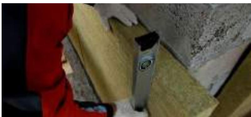
Рис. 7.31. Приклейка плиты тепло-, звукоизоляции к стене
