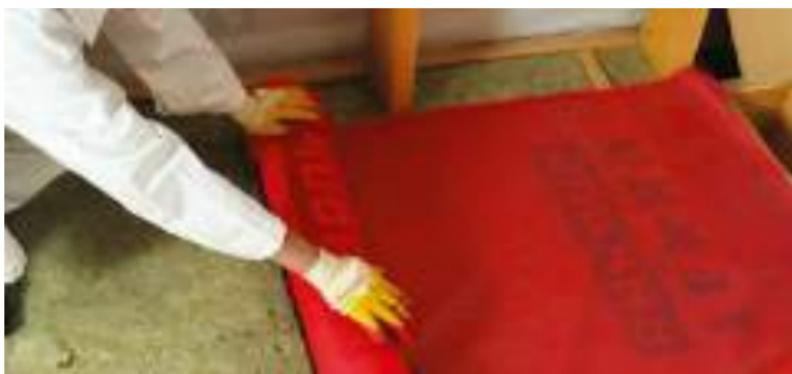
Рис. 4.12. Монтаж ветро-, влагозащитной мембранны
