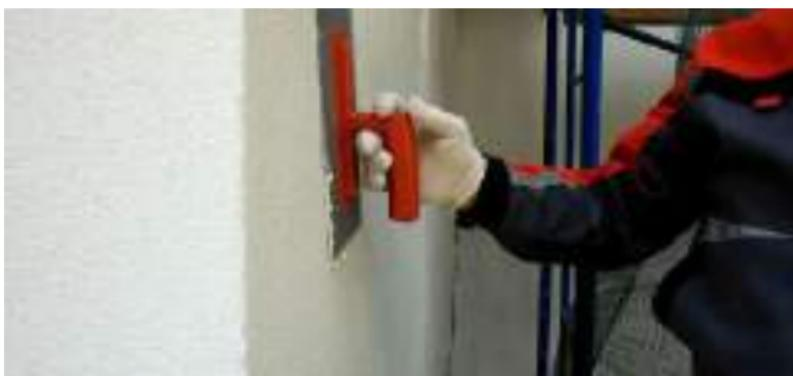
Рис. 7.41. Нанесение декоративного слоя штукатурки
