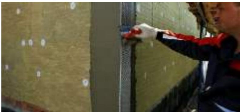
Рис. 7.37. Установка усиливающих профилей на углах здания
