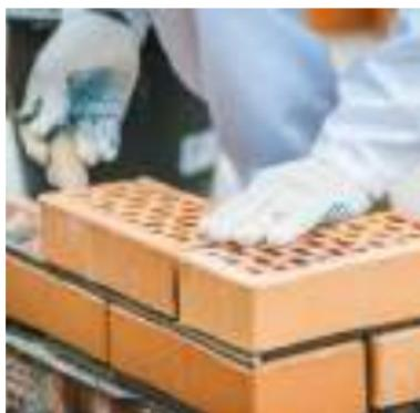
Рис. 7.10. Монтаж внешней версты
