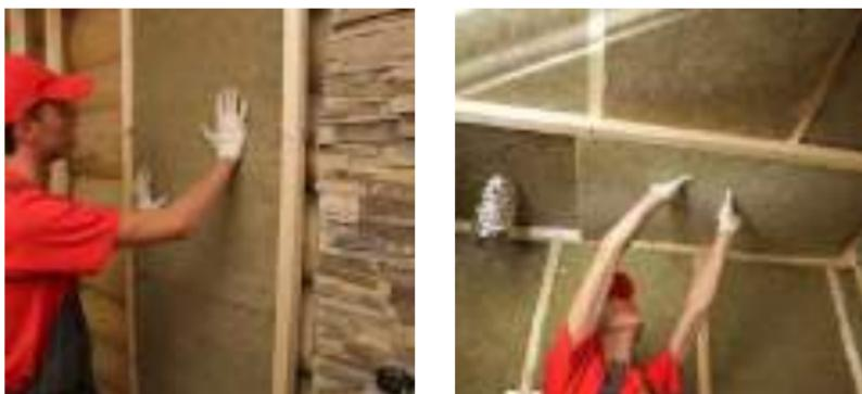
Рис. 6.14. Укладка плит теплоизоляции
