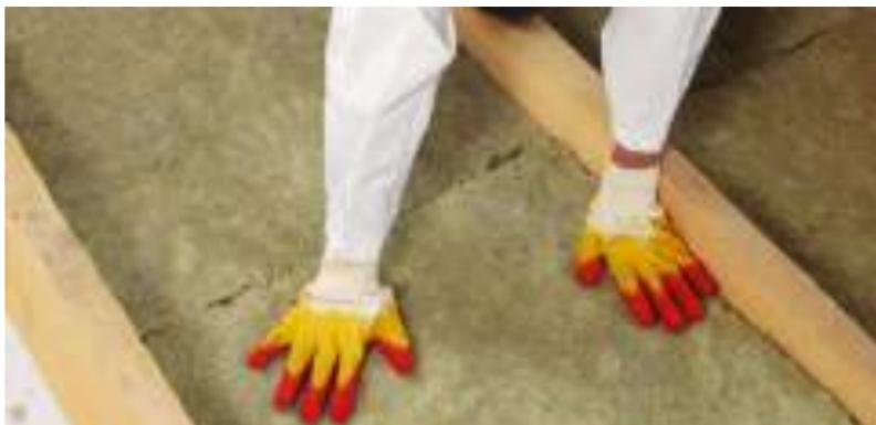
Рис. 4.11. Монтаж теплоизоляции между балками
