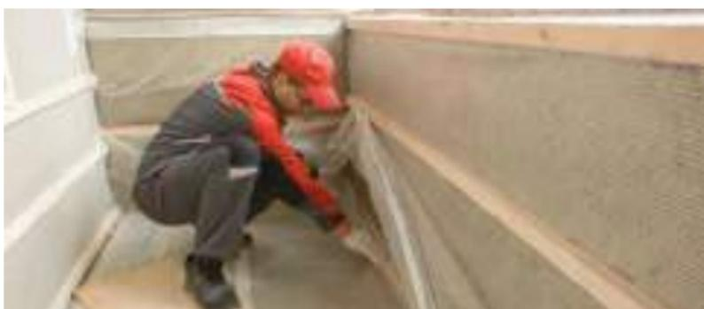
Рис. 7.51. Монтаж пароизоляционной пленки
