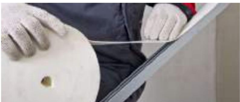
Рис. 6.9. Приклейка уплотнительной ленты к профилям
