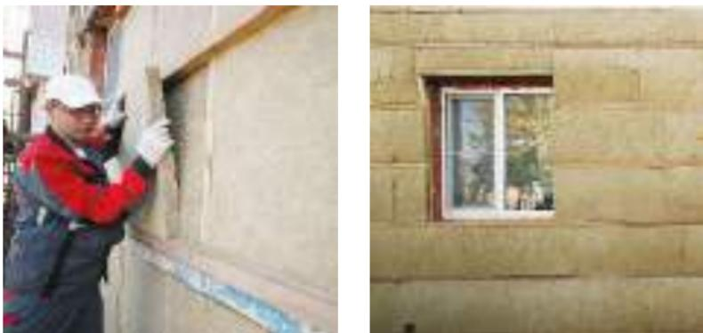
Рис. 7.4. Монтаж теплоизоляционных плит в горизонтальный каркас
