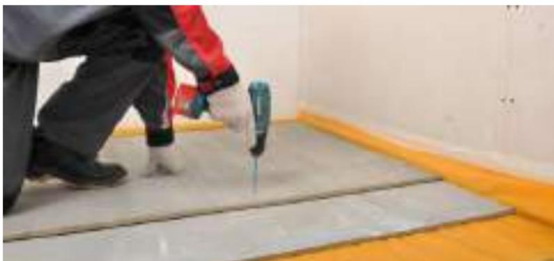
Рис. 5.11. Устройство сборной стяжки
