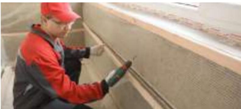
Рис. 7.47. Монтаж контррейки
