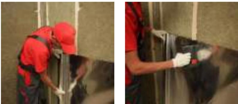
Рис. 6.15. Монтаж пароизоляции
