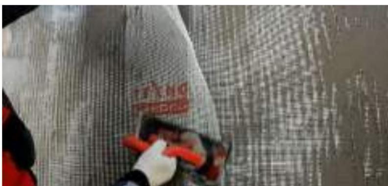
Рис. 7.39. Армирование базового штукатурного слоя стеклосеткой
