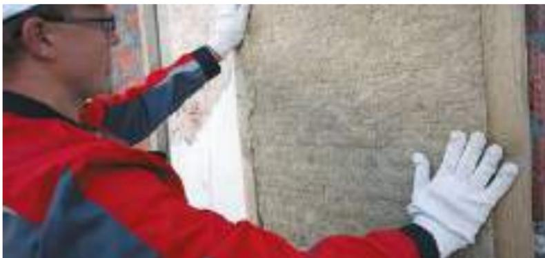
Рис. 7.2. Монтаж теплоизоляционных плит в вертикальный каркас
