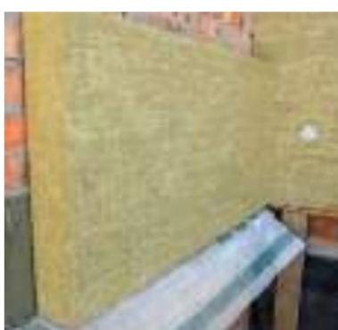
Рис. 7.26.б. Установка опорного профиля для первого ряда теплоизоляции с применением деревянного бруса
