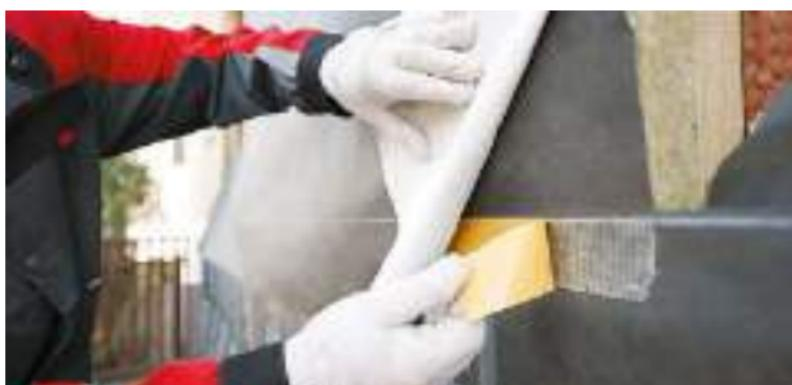
Рис. 7.5. Монтаж и проклейка стыков полотен ветро-, влагозащитной мембранны
