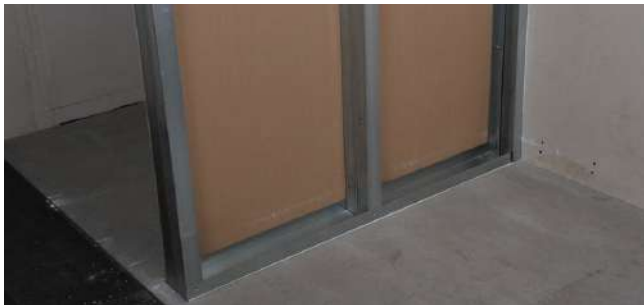
Рис. 6.5. Обшивка первой стороны листом ГКЛ
