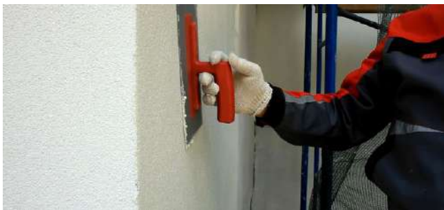
Рис. 7.41. Нанесение декоративного слоя штукатурки
