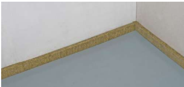
Рис. 5.7. Выравнивание пола, монтаж полос из каменной ваты по периметру
