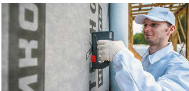
Рис. 7.22. Монтаж ветро-, влагозащитной мембраны
