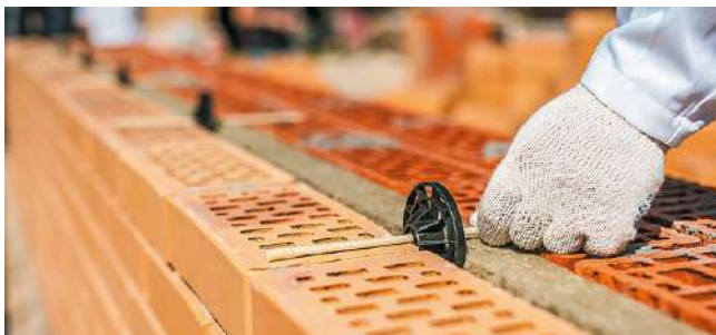
Рис. 7.14. Установка гибких связей
