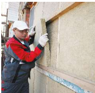
Рис. 7.4. Монтаж теплоизоляционных плит в горизонтальный каркас
