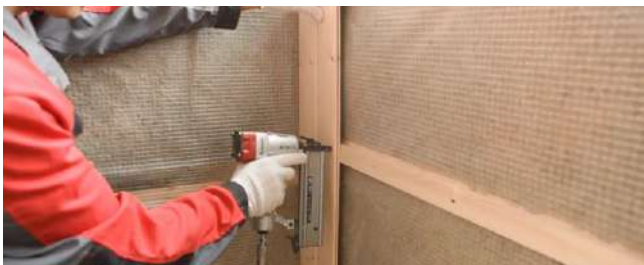
Рис. 7.48. Устройство внутренней обшивки
