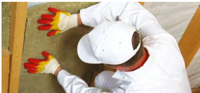
Рис. 4.3.6. Монтаж теплоизоляции враспор между стропилами
