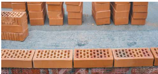
Рис. 7.8. Гидроизоляционная отсечка
