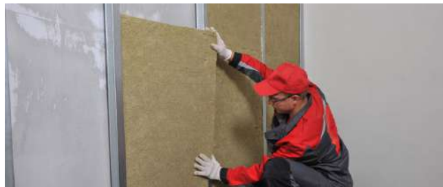
Рис. 6.11. Монтаж тепло-, звукоизоляционных плит
