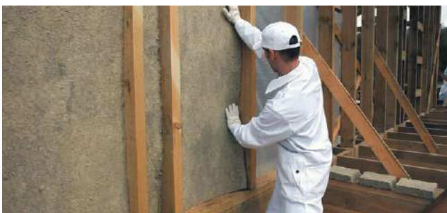
Рис. 7.21. Монтаж теплоизоляционных плит
