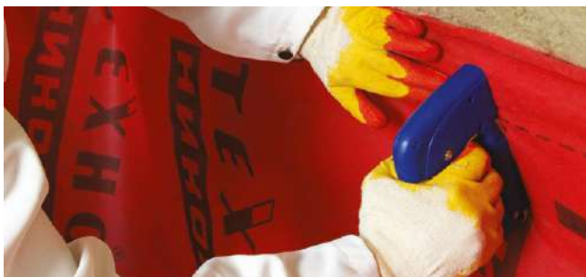
Рис. 4.5. Укладка и фиксация пароизоляционной пленки
