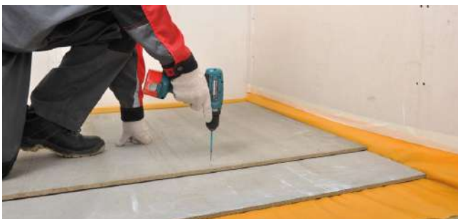
Рис. 5.11. Устройство сборной стяжки
