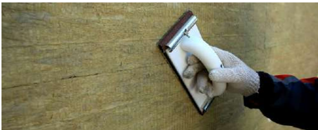
Рис. 7.34. Шлифовка стыков плит теплоизоляции наждачной бумагой
