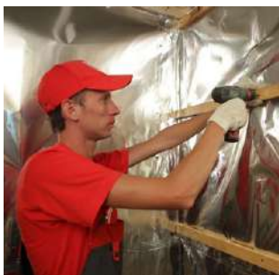
Рис. 6.17. Устройство внутренней обшивки
