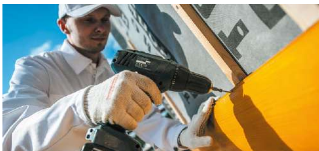
Рис. 7.23.а. Монтаж облицовочного материала
