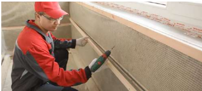
Рис. 7.47. Монтаж контррейки
