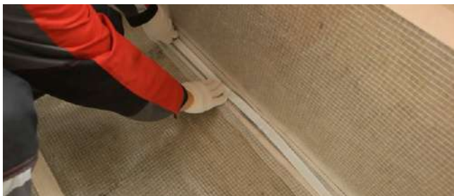
Рис. 7.52. Проклейка нахлестов пароизоляции
