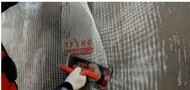
Рис. 7.39. Армирование базового штукатурного слоя стеклосеткой
