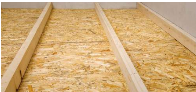
Рис. 5.1. Подшивка лаг снизу
