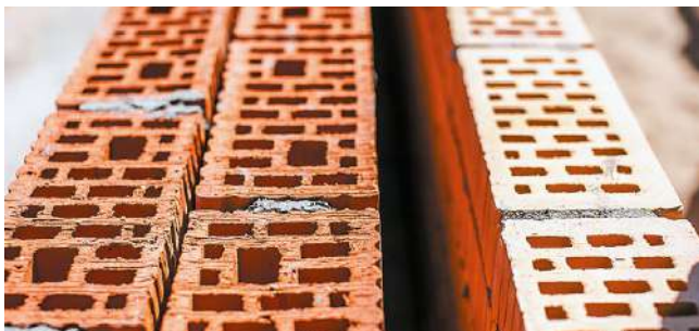
Рис. 7.11. Монтаж внутренней версты
