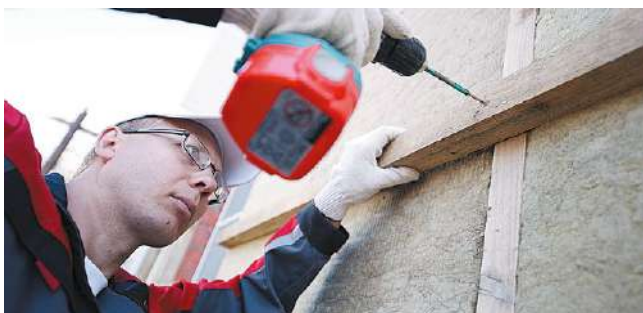
Рис. 7.3. Установка горизонтального каркаса
