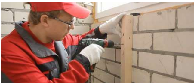
Рис. 7.42. Установка вертикального каркаса под теплоизоляцию
