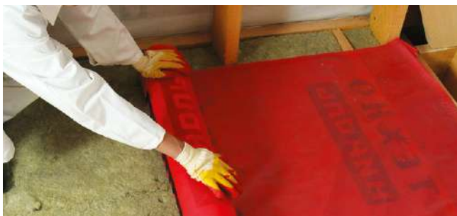
Рис. 4.12. Монтаж ветро-, влагозащитной мембраны
