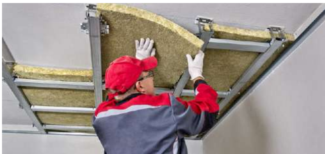
Рис. 5.21. Укладка плит ТЕХНОАКУСТИК
