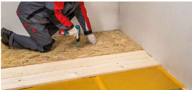
Рис. 5.4.6. Монтаж черного пола
