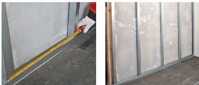
Рис. 6.10. Установка направляющего и стоечного профилей
