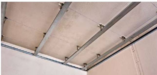
Рис. 5.20. Установка подвесов и потолочного профиля
