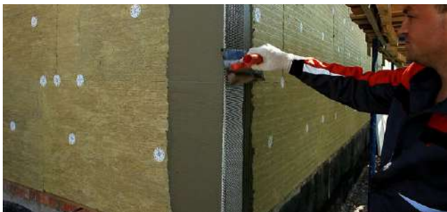
Рис. 7.37. Установка усиливающих профилей на углах здания
