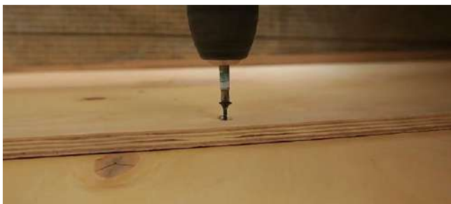
Рис. 7.54. Установка покрытия пола
