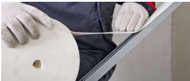
Рис. 6.9. Приклейка уплотнительной ленты к профилям
