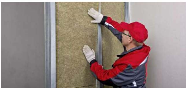
Рис. 6.6. Укладка плит ТЕХНОАКУСТИК
