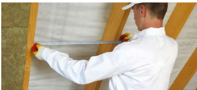
Рис. 4.2. Подготовленная система для дальнейшего монтажа теплоизоляции
