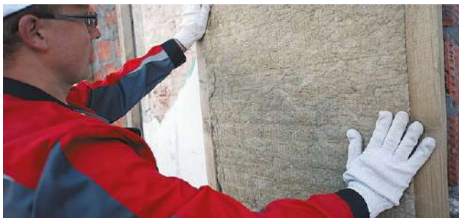
Рис. 7.2. Монтаж теплоизоляционных плит в вертикальный каркас
