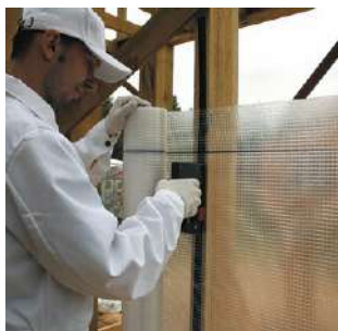
Рис. 7.20. Монтаж пароизоляционной пленки
