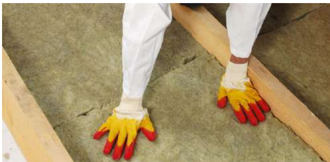
Рис. 4.11. Монтаж теплоизоляции между балками
