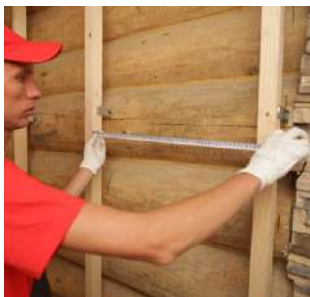
Рис. 6.13. Установка каркаса под теплоизоляцию
