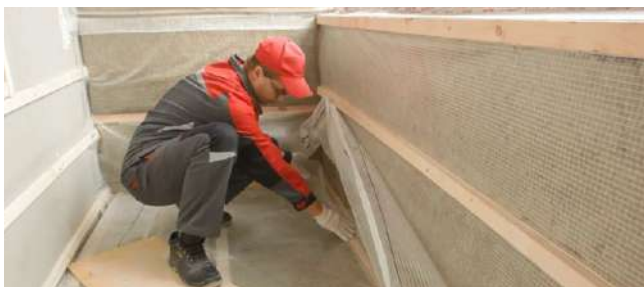
Рис. 7.51. Монтаж пароизоляционной пленки
