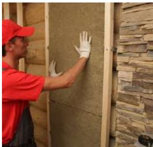
Рис. 6.14. Укладка плит теплоизоляции
