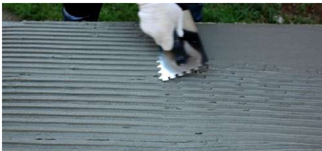
Рис. 7.28. Нанесение клеевого состава на плиту сплошным методом приклейки
