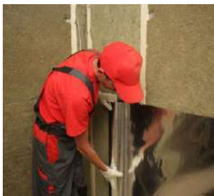
Рис. 6.15. Монтаж пароизоляции
