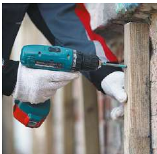
Рис. 7.1. Крепление вертикальных стоек деревянного каркаса
