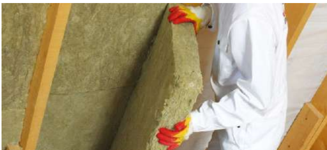
Рис. 4.3.а. Монтаж теплоизоляции враспор между стропилами
