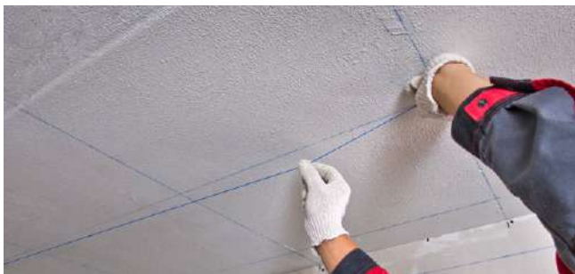
Рис. 5.19. Разметка стен и потолка для крепления направляющего профиля и подвесов
