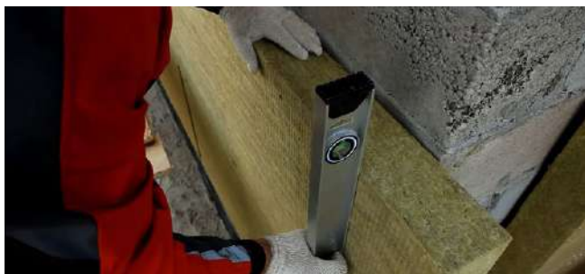
Рис. 7.31. Приклейка плиты тепло-, звукоизоляции к стене
