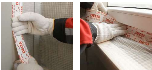
Рис. 7.53. Проклейка примыканий пароизоляции к стенам и окну
