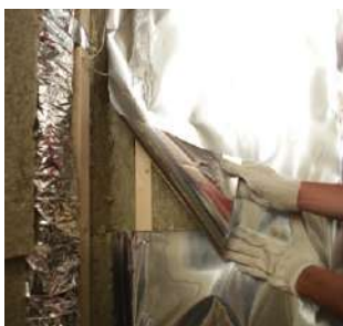
Рис. 6.16. Проклейка стыков пароизоляции
