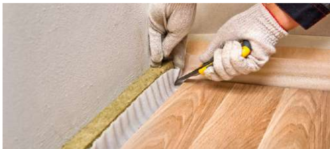
Рис. 5.15. Подрезка звукоизоляционных плит по периметру на уровне чистого пола
