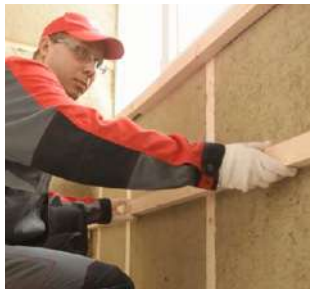
Рис. 7.44. Установка горизонтального каркаса под теплоизоляцию
