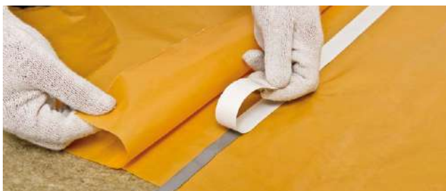
Рис. 5.3. Монтаж и проклейка нахлестов пароизоляционной пленки
