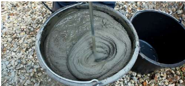
Рис. 7.27. Замешивание клея для приклейки теплоизоляции
