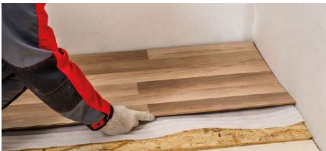
Рис. 5.5. Монтаж чистового покрытия
