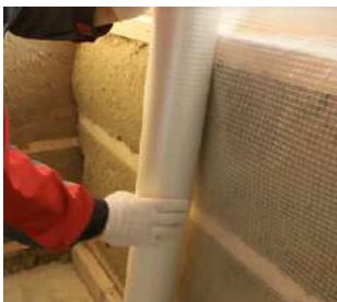
Рис. 7.46. Монтаж пароизоляции
