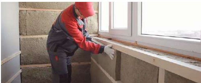
Рис. 7.45. Укладка плит теплоизоляции второго слоя
