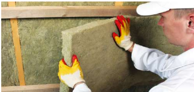
Рис. 4.4.б. Укладка второго слоя теплоизоляции
