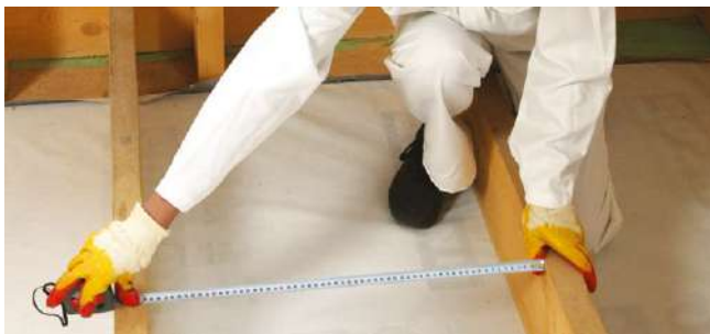
Рис. 4.9. Смонтированная пароизоляционная пленка
