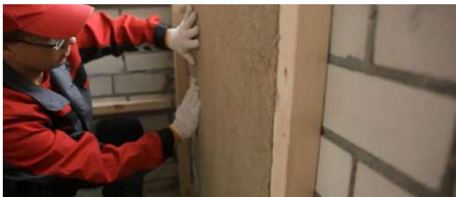
Рис. 7.43. Укладка плит теплоизоляции первого слоя
