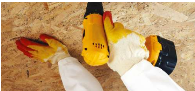
Рис. 4.10. Подшивка потолка листами ОСП
