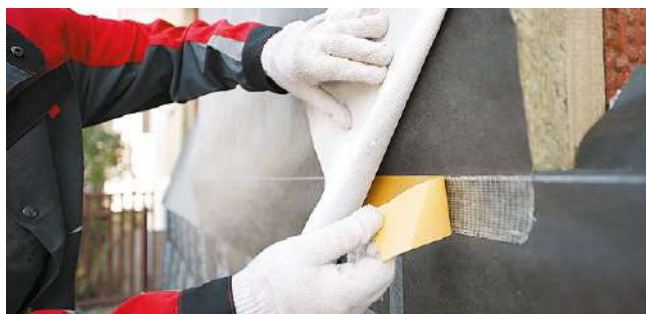
Рис. 7.5. Монтаж и проклейка стыков полотен ветро-, влагозащитной мембраны
