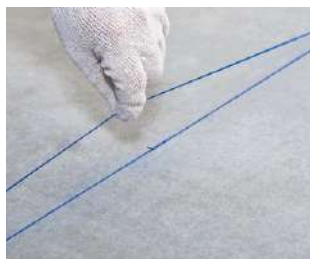
Рис. 6.2. Разметка основания
