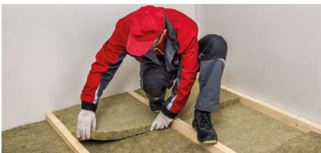
Рис. 5.2. Монтаж теплоизоляции враспор между лагами
