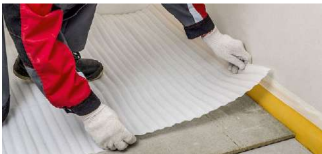
Рис. 5.14. Укладка подложки под финишное покрытие пола
