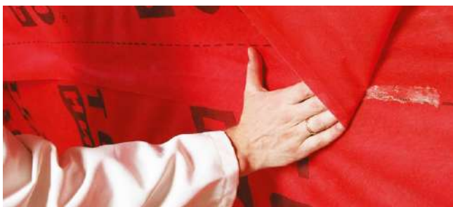
Рис. 4.6. Проклейка стыков пароизоляционной пленки
