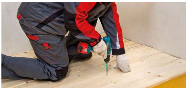
Рис. 5.4.а. Монтаж чернового пола
