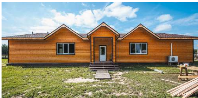
Рис. 7.23.б. Монтаж облицовочного материала
