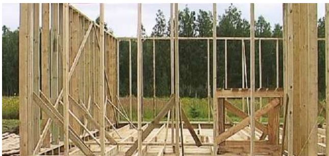
Рис. 7.19. Установка деревянного каркаса
