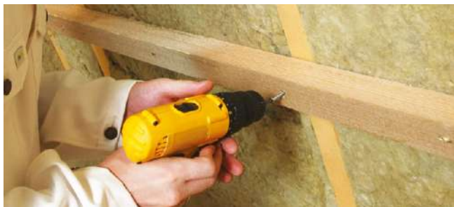
Рис. 4.4.а. Укладка второго слоя теплоизоляции
