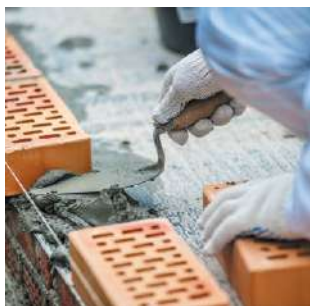
Рис. 7.10. Монтаж внешней версты
