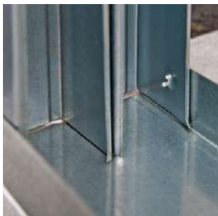
Рис. 6.4. Установка стоечного профиля.
