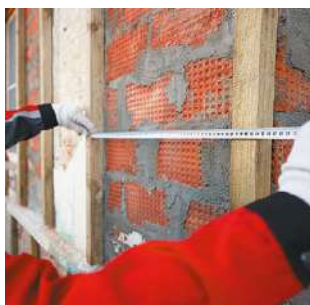
Рис. 7.1. Крепление вертикальных стоек деревянного каркаса
