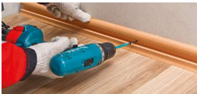
Рис. 5.17. Крепление плинтуса
