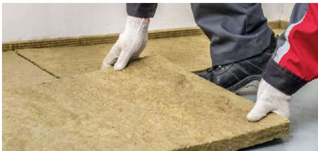
Рис. 5.8. Укладка плит ТЕХНОФЛОР СТАНДАРТ
