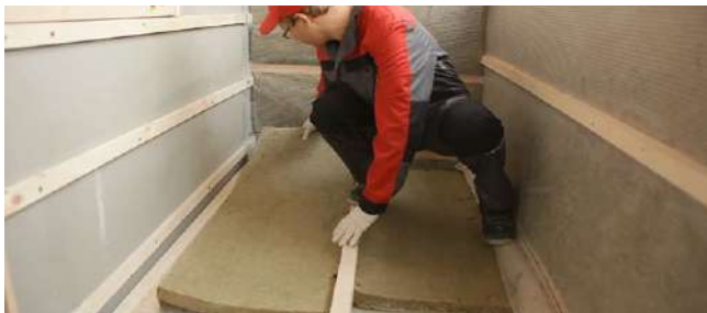
Рис. 7.50. Укладка теплоизоляционных плит
