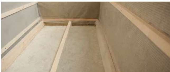
Рис. 7.49. Монтаж деревянных лаг на пол
