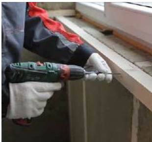
Рис. 7.44. Установка горизонтального каркаса под теплоизоляцию
