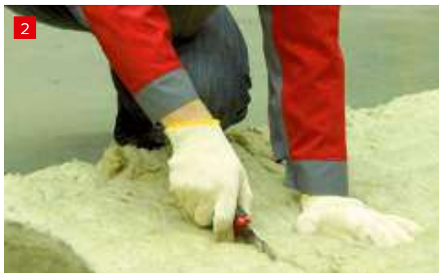
2 Выкройка огнезащитных матов
