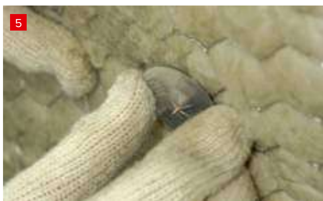
5 Установка прижимных шайб
