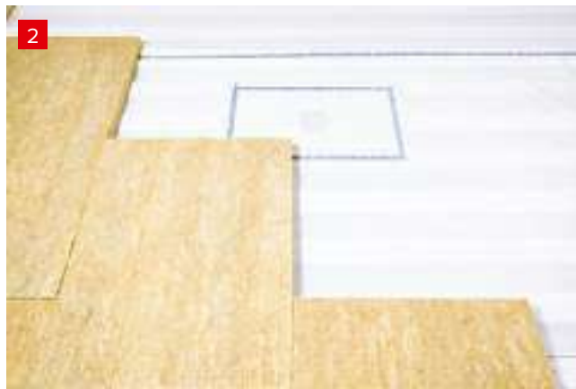
Укладка нижнего теплоизоляционного слоя
