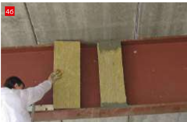
Монтаж дополнительных монтажных элементов (вставок)
