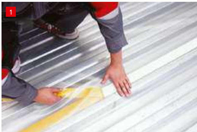
Укладка пароизоляции
