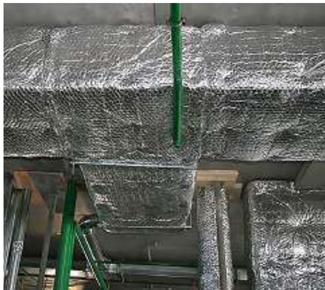
Рис. 4.2. Огнезащита воздуховода
