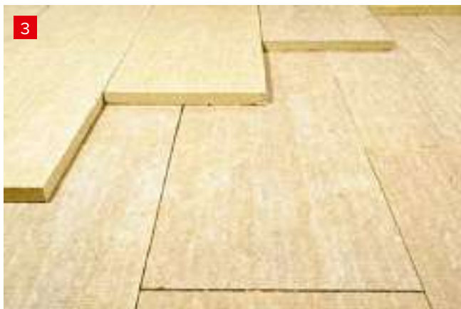
Укладка верхнего теплоизоляционного слоя
