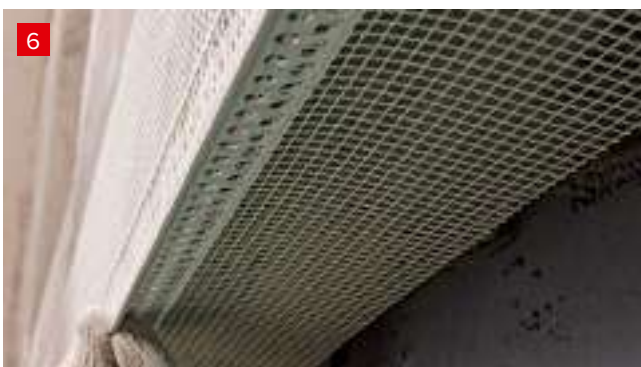
Устройство защитно-декоративного слоя
