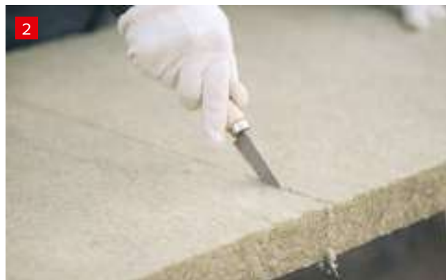
Резка плит ТЕХНО ОЗМ
