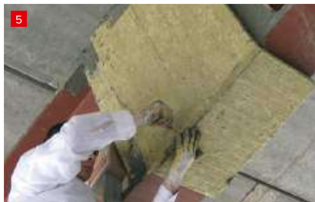
Монтаж огнезащитных плит ТЕХНО ОЗМ
