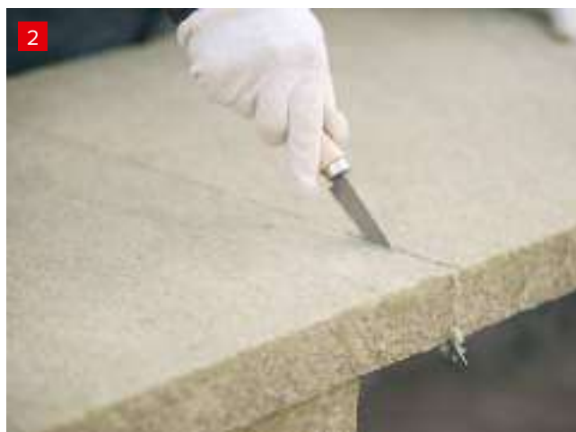
Резка плит TEXNO O3B
