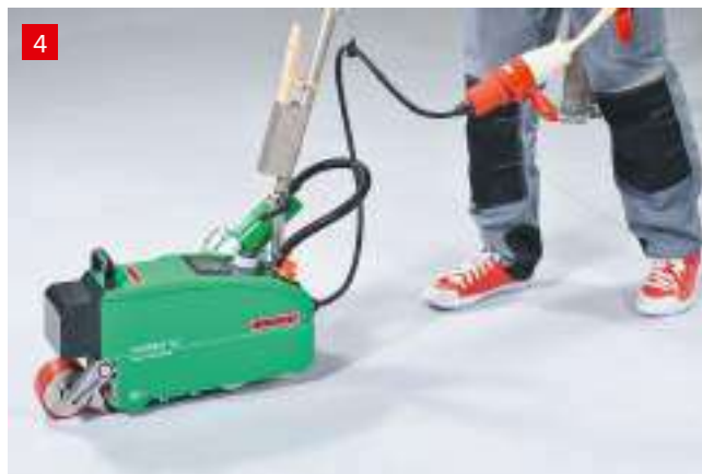
Укладка гидроизоляционного ковра
