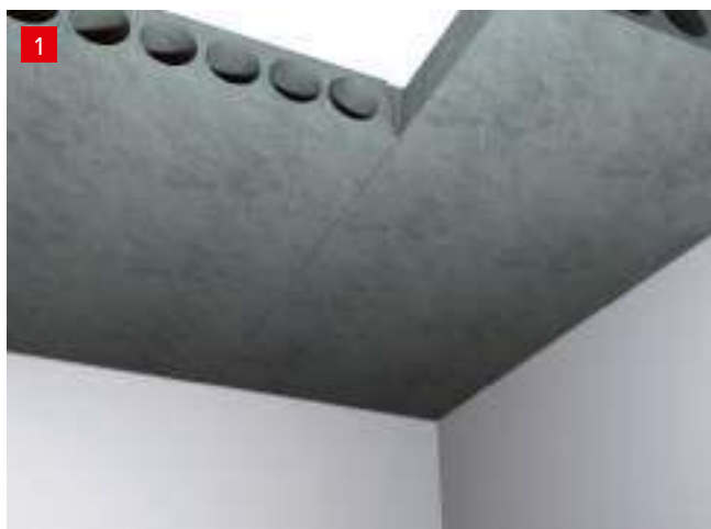
Подготовка поверхности железобетонной плиты
