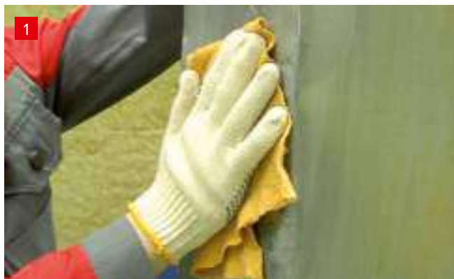
1 Подготовка наружной поверхности воздуховода
